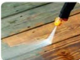
Die Reinigung mit dem Hochdruckreiniger beschädigt das Holz. Spreißel werden aufgestellt und können später beim Barfußgehen zu Verletzungen führen. Die Oberfläche wird durch den Wasserdruck aufgeraut und noch anfälliger gegen Witterungseinflüsse.
